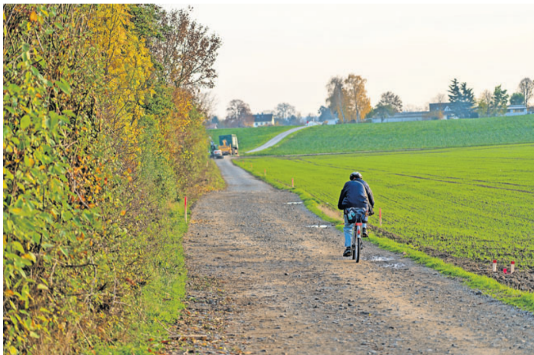
Der Karbener Weg kann endlich ausgebaut werden.
