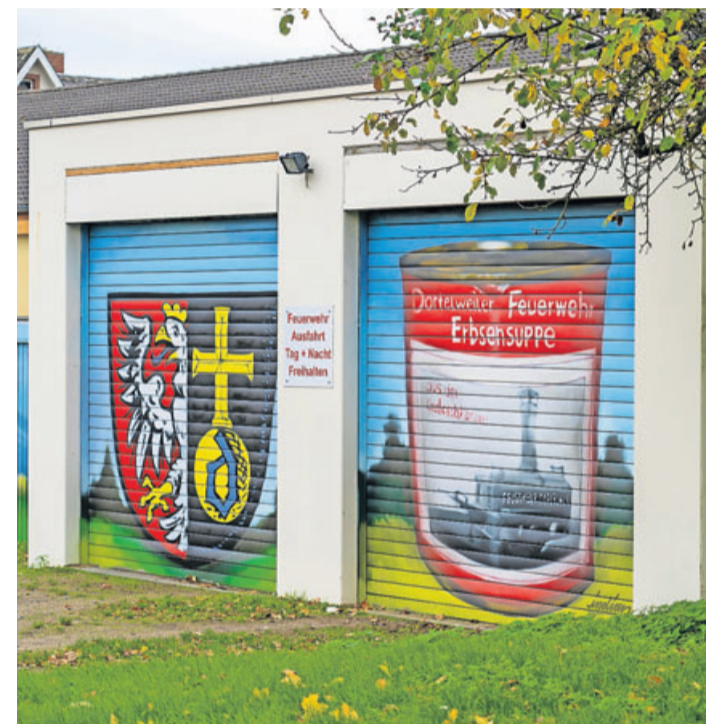
Die neu gestalteten Garagentore der Dortelweiler Feuerwehr.
