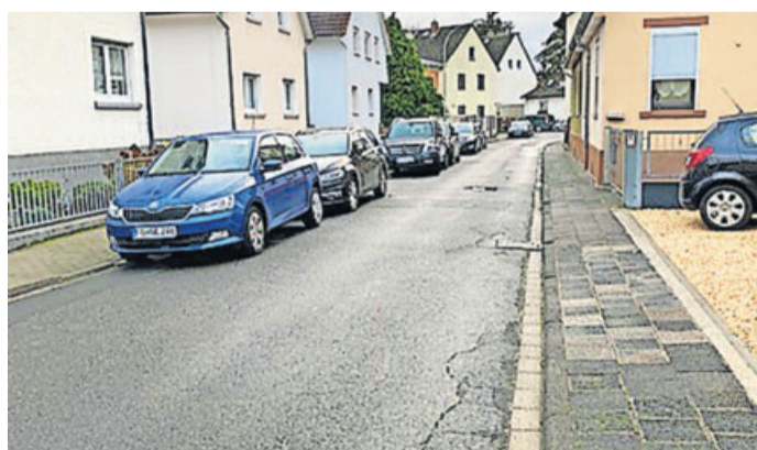
Die Fahrbahn inklusive Kanal und Gehweg soll saniert werden.
