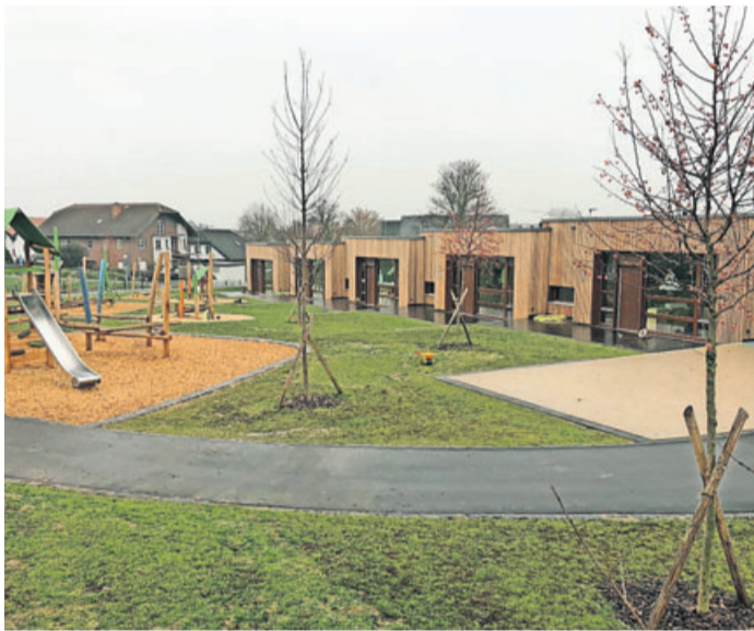
Der Neubau des Kindergartens „Wichtelburg“ ist als erster Schritt klimaneutral erfolgt.
