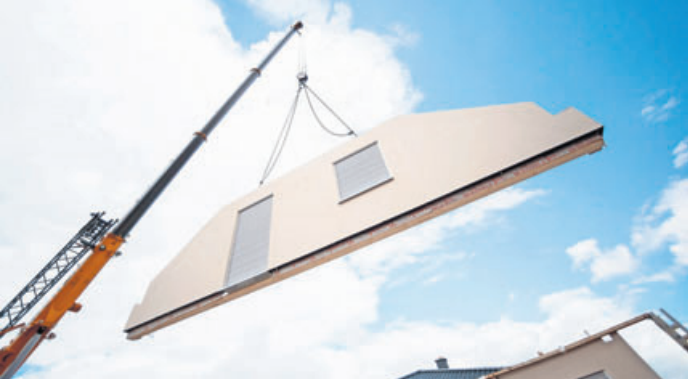
Ein Gebäude kann mit Fertigteilenelementen aufgestockt werden. Solche neuen Obergeschosse sind zum Teil schon mit Küche, Bad und Privaträumen ausgestattet. Foto: Frank Rumpenhorst/dpa-mag
