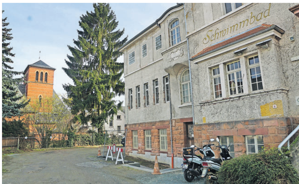
Ein Blick auf die Fassade des 1909 erbauten Jugendstil-Hallenbades in Friedberg. Im linken Hochparterre sind die Glasbausteine durch eigens angefertigte Sprossenfenster ersetzt worden. Dahinter wird gerade die Theater-Bar gebaut.
