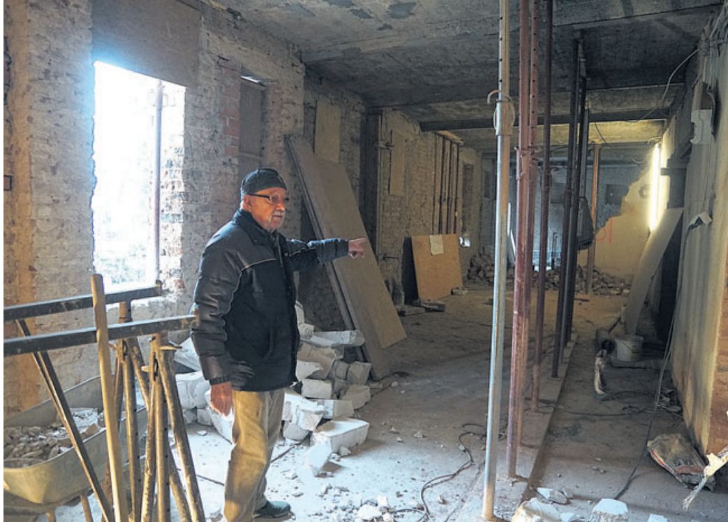
Uli Lang steht im künftigen Foyer des Alten Hallenbades in Friedberg. Im Sommer soll der große Raum für Veranstaltungen benutzbar sein.
