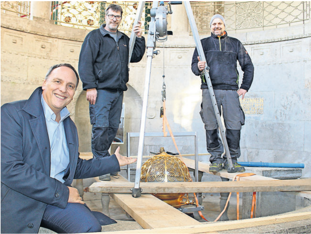
Bürgermeister Klaus Kreß sowie die beiden Mitarbeiter des Heilquellenbetriebs des Kur- und Servicebetriebs, Peter Müller und Jürgen Schmidt (von links) bei der Installation des Brunnens im Kurbrunnentempel.
