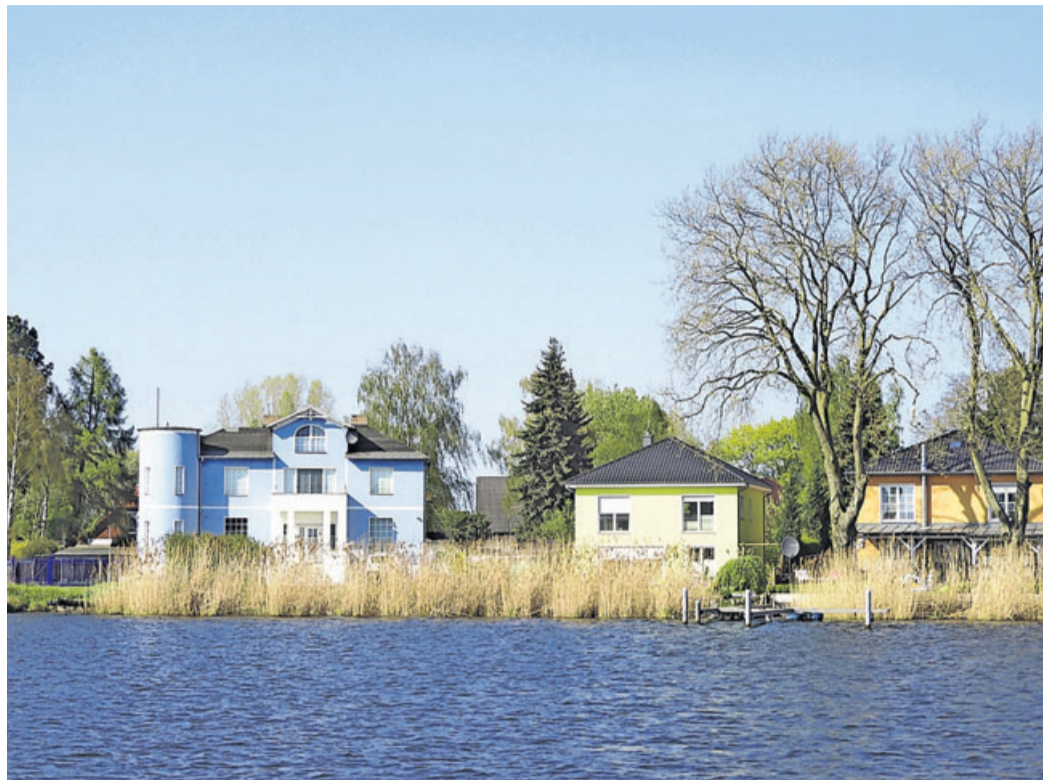
Bauen auf einem Wassergrundstück? Die Bodenbeschaffenheit sollte zuvor einer genauen Prüfung unterzogen werden. Werkfoto: Strachovsky/be.p
