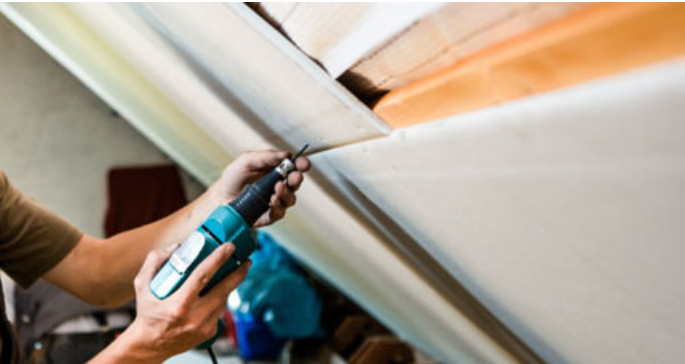
Wer über den vorgeschriebenen Mindestwert hinaus sein Dach dämmt, spart Energie und Geld - und kann darüber hinaus noch Förderung beantragen. Foto: Markus Scholz/dpa-mag
