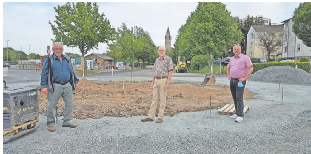
Bürgermeister Dirk Antkowiak, Stadtverordnetenvorsteher Hendrik Hollender und Ortsvorsteher Norbert Simmer (von rechts) freuen sich über den Baufortschritt des neuen Junity-Kreisels.
