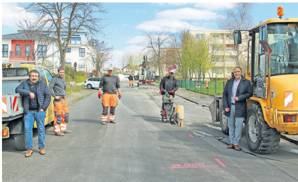
Fachbereichsleiter Stadtentwicklung Jürgen Patscha, die Poliere Christian Fischer und David Allen, Facharbeiter Kay Scharmann und Bürgermeister Klaus Kreß (von links), der sich ein Bild von der Baustelle machte.
