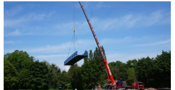
In luftiger Höhe balanciert der Schwerlastkran die neue Niddabrücke in Dortelweil.
