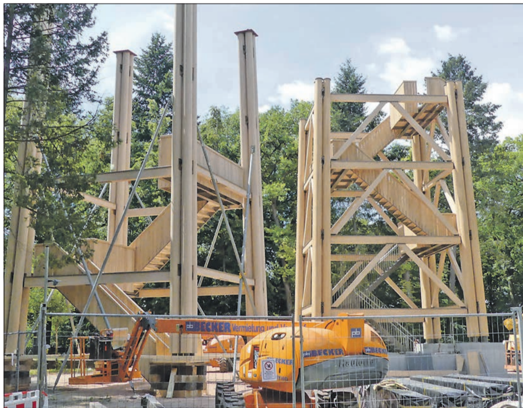
Viel Betrieb herrscht beim Besuch der Orscheler an der Baustelle am Goetheturm. Fotos: bg
