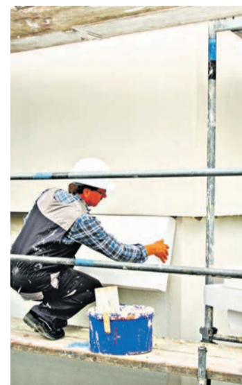
Klimaschutz, geringere Heizkosten, eine höhere Wohnqualität: Dämmen zahlt sich gleich mehrfach aus. Foto: djd/Qualitätsgedämmt/imito-foto - stock.adobe.com
