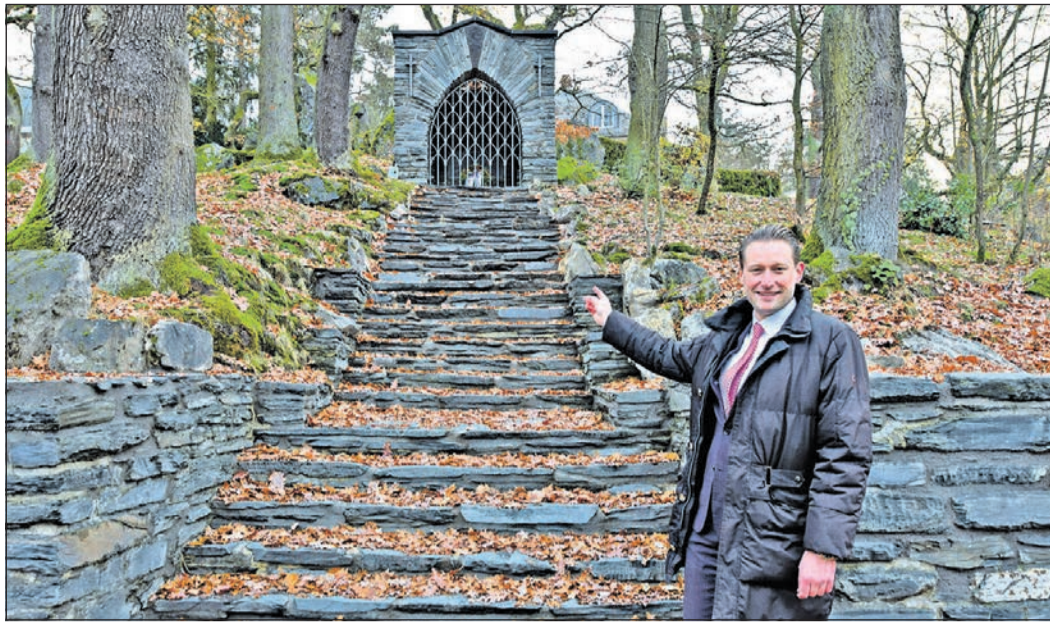
Oberbürgermeister Alexander Hetjes zeigt den erneuerten Treppenaufgang aus schwarzen Schieferplatten, der zum Denkmal führt. Foto: Stadt Bad Homburg
