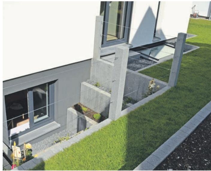
So könnte eine moderne Kellerlösung aussehen, bei der für viel Lichtzufuhr gesorgt ist. Foto: djd/KNECHT Kellerbau
