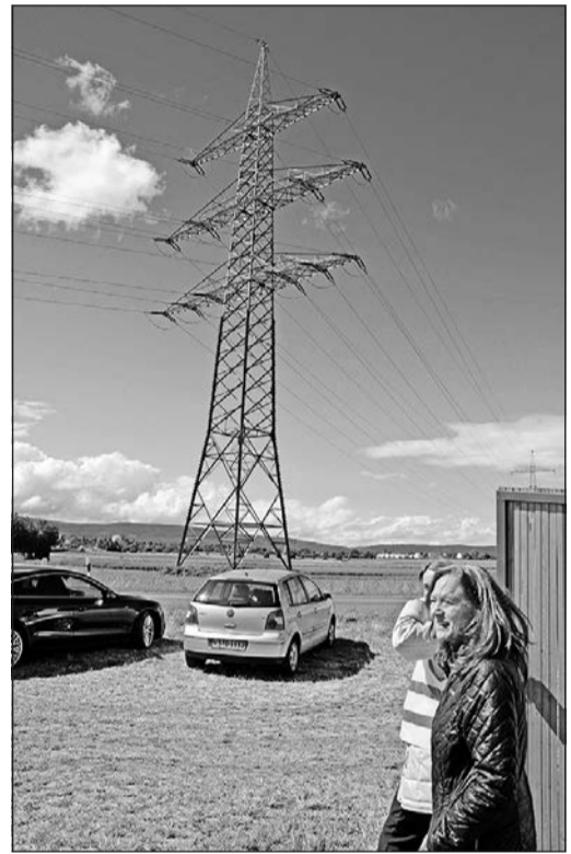
Ein geplanter Funkmast im Weißkirchener Feld erfreut nicht alle Weißkirchener, links die Ortsgrenze. Hier soll er aufgestellt werden, wohl nicht ganz so hoch wie die Masten der Stromleitungen. Foto: js
