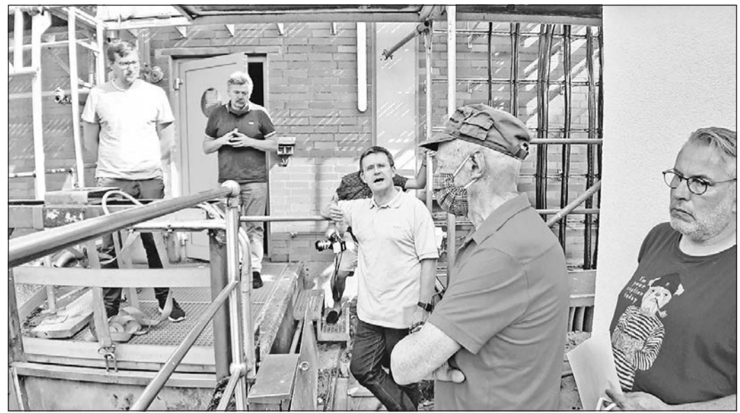
Andreas Holzmann, Bernd Feger und Betriebsleiter Michael Maag vom BSO (v. l.) führen durch die Anlage. Fotos: Niesel-Heinrichs
