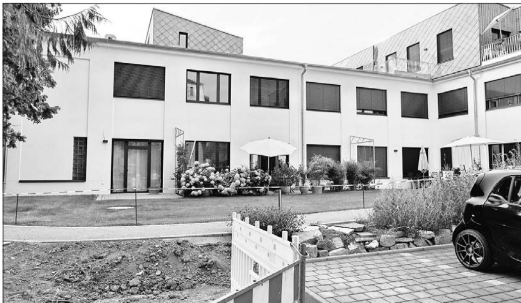
Von der Straße aus nicht einsehbar ist der von den Wohnungen aus direkt zugängliche Gemeinschaftsgarten. Foto: fch
