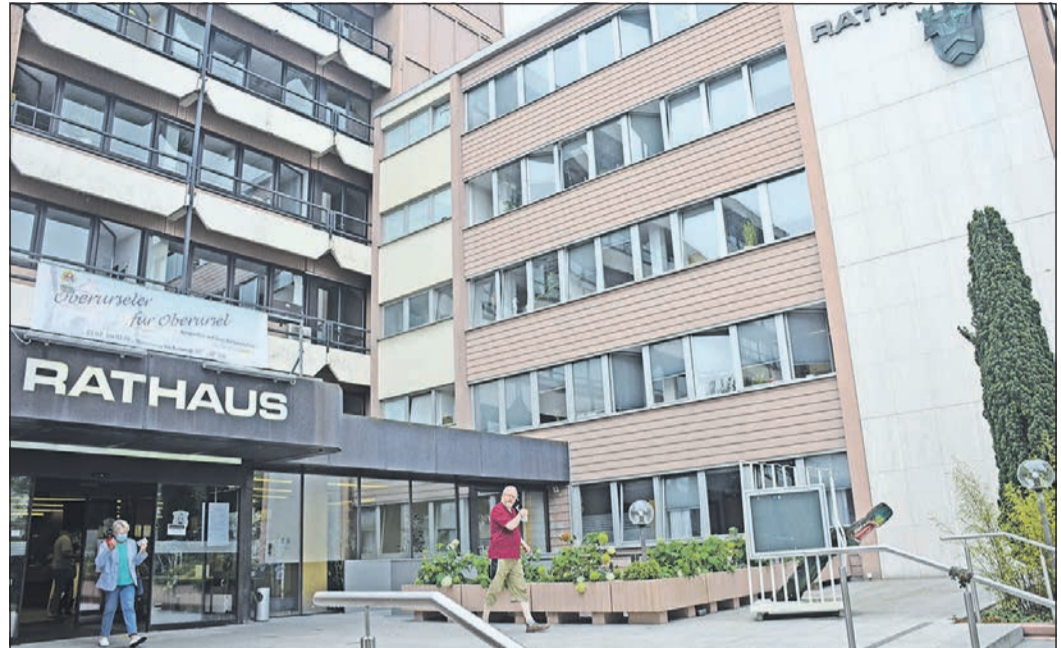
Der ungeliebte B-Bau (rechts) steht bei den Planungen für den Rathausumbau langfristig zur Disposition. Foto: js
