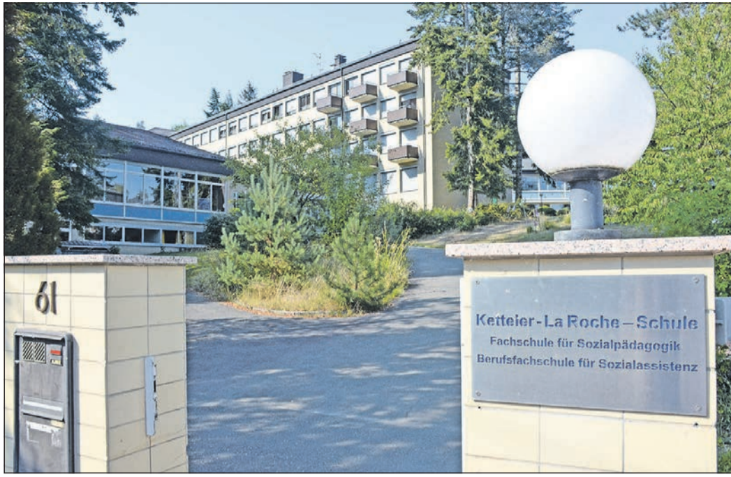
Noch sind die letzten Tage im Altenhöfer Weg nicht gezählt, doch die Ketteler-La Roche-Schule lechzt nach Umzug in den Süden der Stadt in ein neues Schulgebäude mit Wohnheim für die Studierenden. Foto: js
