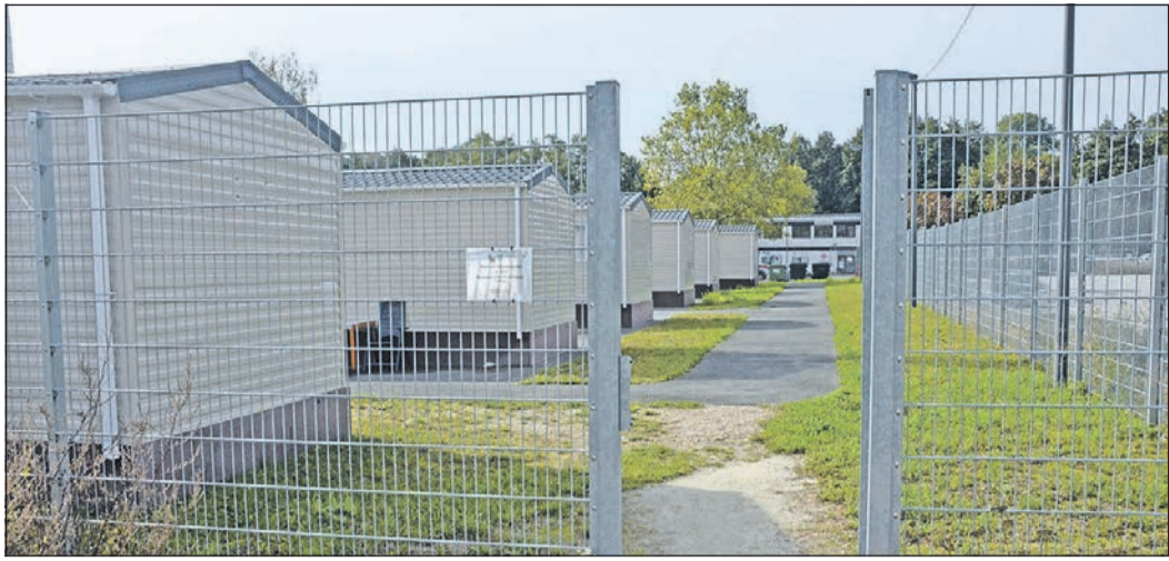
Akkurat aufgereiht und ordentlich eingezäunt sind die „Mobile Wohnheime“ in der oberen Marxstraße auf der ehemaligen KHD-Wiese. Im November soll eine zweite Reihe mit acht Containern für die Unterbringung von sonst obdachlosen Menschen dazukommen. Foto: js
