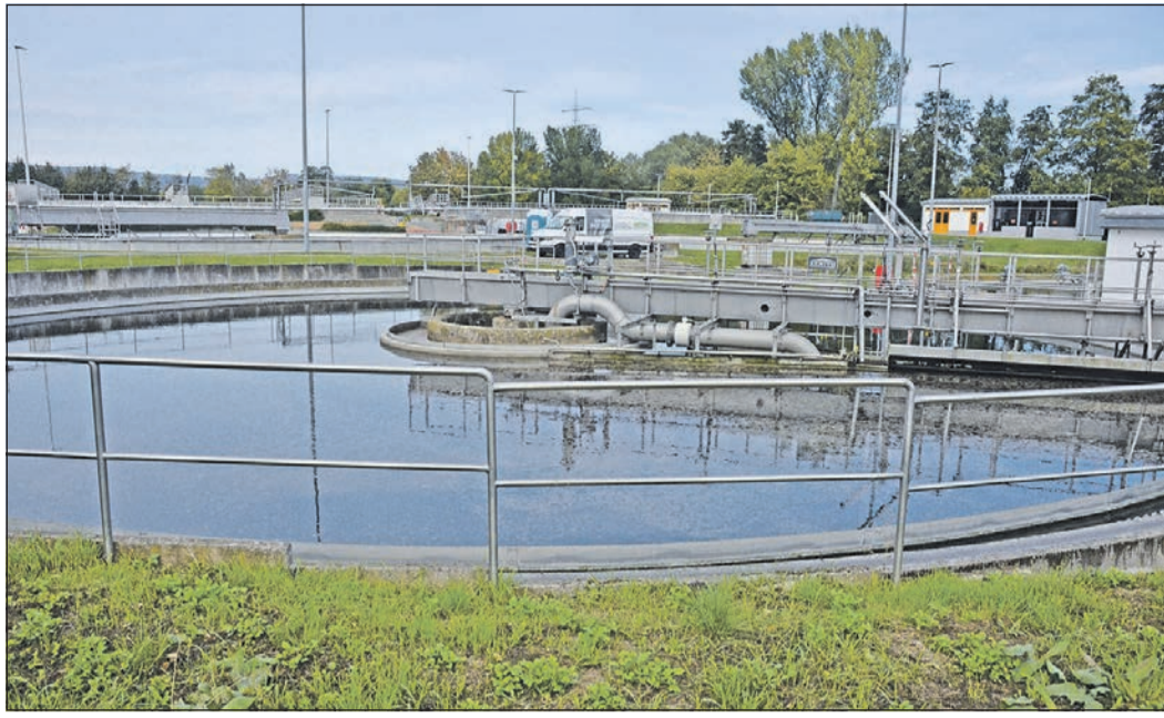
Hier fließt alles zusammen, was aus Oberurseler Haushalten in die Kanalisation gelangt. Um die Kläranlage zu finanzieren, müssen die Haushalte demnächst höhere Gebühren für die Abwasserentsorgung bezahlen. Foto: js
