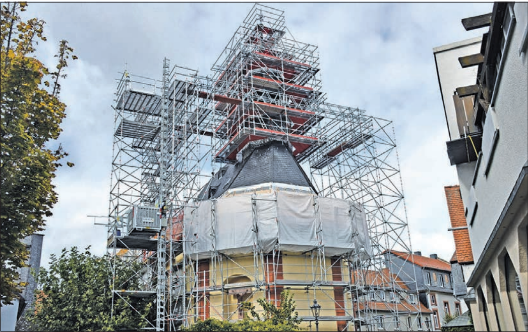
Hochgerüstet: Bis über den Turmhelm hinaus, an dessen Spitze die heilige Barbara als Schutzpatronin der Kirche wacht, ist die fast 300 Jahre alte Hospitalkirche derzeit filigran eingerüstet. Am höchsten Punkt wird die diffizilste Arbeit bei der Dachsanierung erledigt. Foto: js
