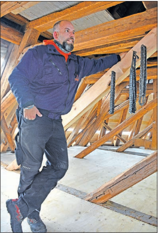
Der Meister im neuen Dachstuhl: An einem frisch eingebauten Balken aus Kiefernholz, der mit uralten Eichenbalken verknüpft wird, hängen verschiedene Ketten für die leichten Motorsägen. Hier muss jede Traglastverteilung genau stimmen. Foto: js
