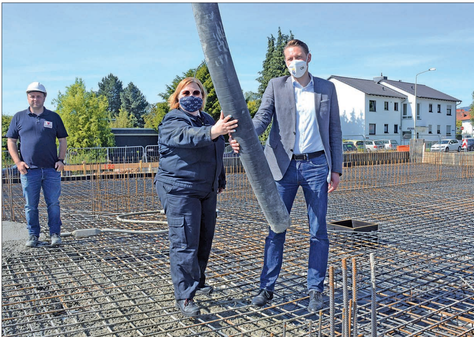
Symbolischer Akt mit Hand am Schlauch: Wehrführerin Angela Schlottmann und Oberbürgermeister Alexander Hetjes beim „Gießen“ der ersten Betonplatte. Foto: js
