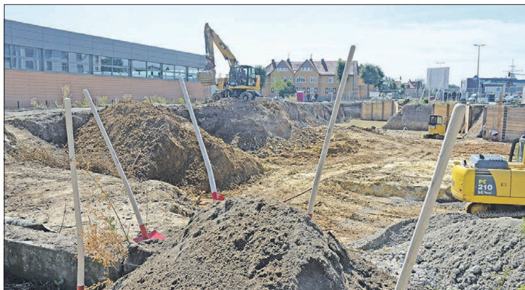
Großbaustelle neben der neuen Sporthalle der Humboldtschule: Das Loch für die Tiefgarage ist bereits gegraben, auf dem ehemaligen Kerschensteiner-Gelände sollen 49 Wohnungen gebaut werden. Foto: Streicher
