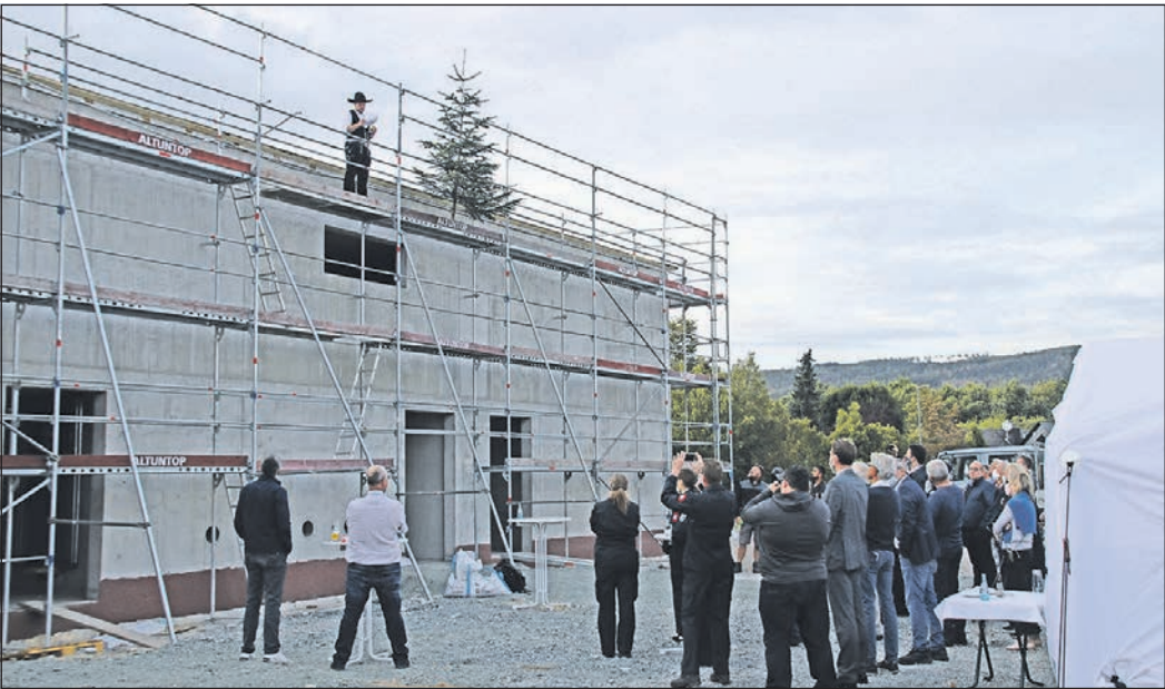
Zimmermann David Ruhl aus Lauterbach verliest vor den Feuerwehrleuten der Freiwilligen Feuerwehr Dornholzhausen und weiteren Anwesenden den Richtspruch. Foto: Ehmler
