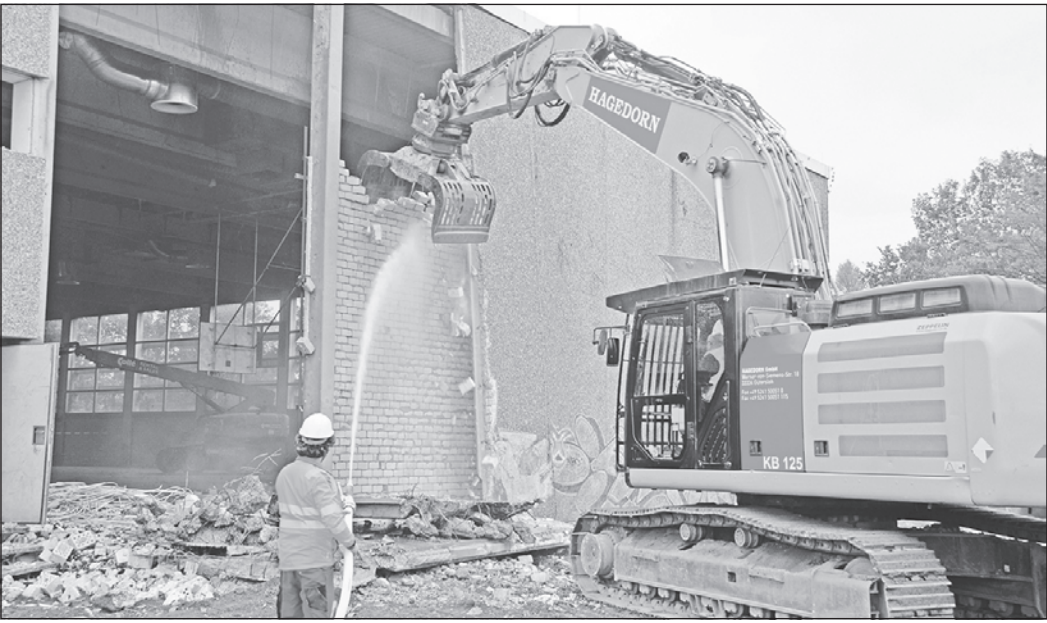
Der Abrissbagger frisst sich in die Kieselsteinverblendung der Rückwand der Albin-Göhring-Halle, knabbert sich Stück für Stück voran, bis die Wand in Teilstücken einbricht. Foto: js
