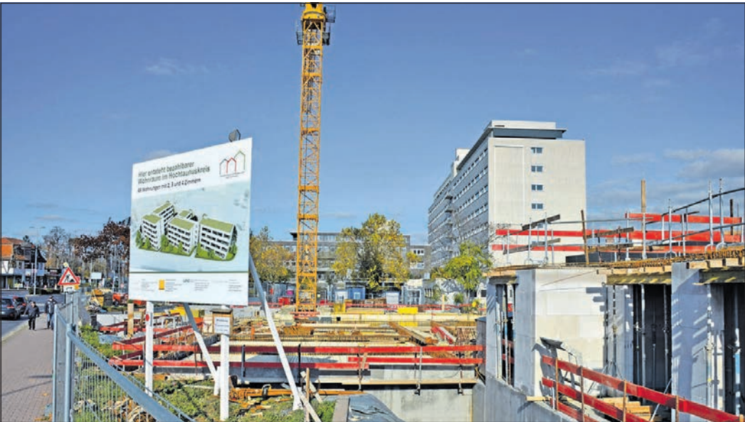
„Hier entsteht bezahlbarer Wohnraum“ steht auf dem Bauschild am ehemaligen Kerschensteiner-Areal. „Preisgedämpft“ werden die Kosten gleichwohl nicht sein. Eine städtische Wohnungsbaugesellschaft soll Abhilfe leisten. Foto: js
