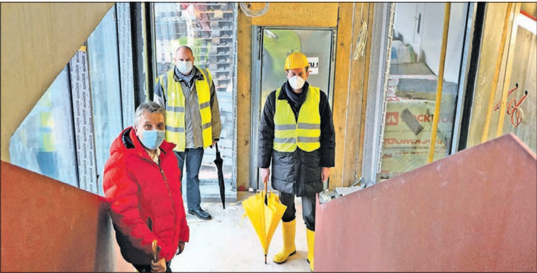
Auf der Baustelle der Maria-Scholz-Schule (v. l.): Landrat Ulrich Krebs, Reiner Plomer, Leiter des Kreis-Hochbauamts, und Oberbürgermeister Alexander Hetjes. Foto: Stadt Bad Homburg
