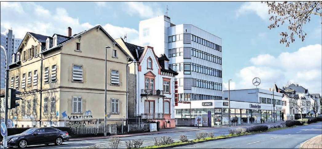
Blick auf das Senger-Areal vom Hessenring/Berliner Platz aus mit der seit vielen Jahren leerstehenden Bauruine eines früheren Holzunternehmens (vorne links). Foto: Streicher
