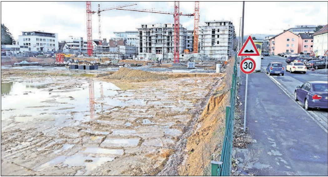
Beim Neubauvorhaben auf dem Vickers-Areal zwischen Frölingstraße und Schleußnerstraße ist erstmalig nach mehr als 20 Jahren wieder der Bau von Wohnungen im geförderten Segment vorgesehen. Foto: Streicher
