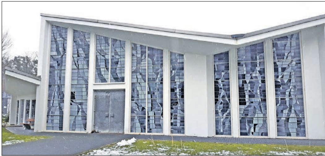
Schlichte Architektur im modernen Gewand, Glasfenster, die bei Sonnenlicht einen warmen Glanz in das Innere der Trauerhalle werfen. Architekt Friedel Kern und der Künstler Georg Hieronymi haben ein zeitlos passendes, zurückhaltendes Gesamtwerk gestaltet. Foto: js
