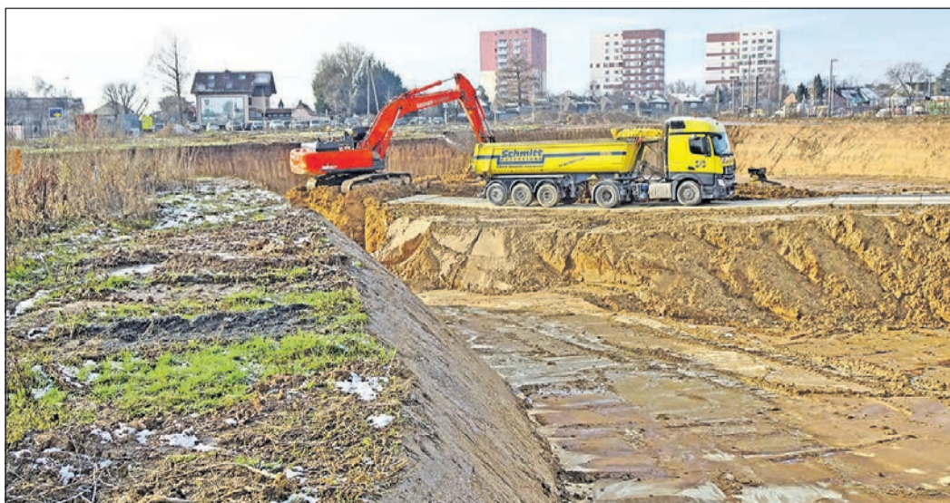
Die größte Baustelle der Stadt im Gewerbegebiet Gründchen: Die Bagger haben sich bis zum Boden der Tiefgarage des Central-Apotheken-Projekts durchgefressen. Foto: HB
