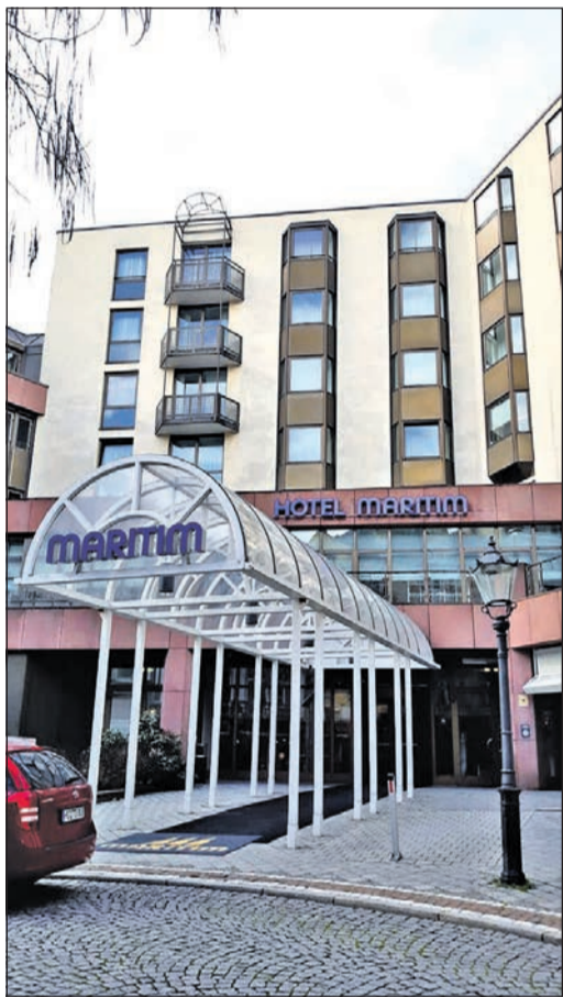
Die meisten der 148 Zimmer des Maritim-Hotels im Herzen der Bad Homburger Innenstadt stehen leer. Fotos: Streicher
