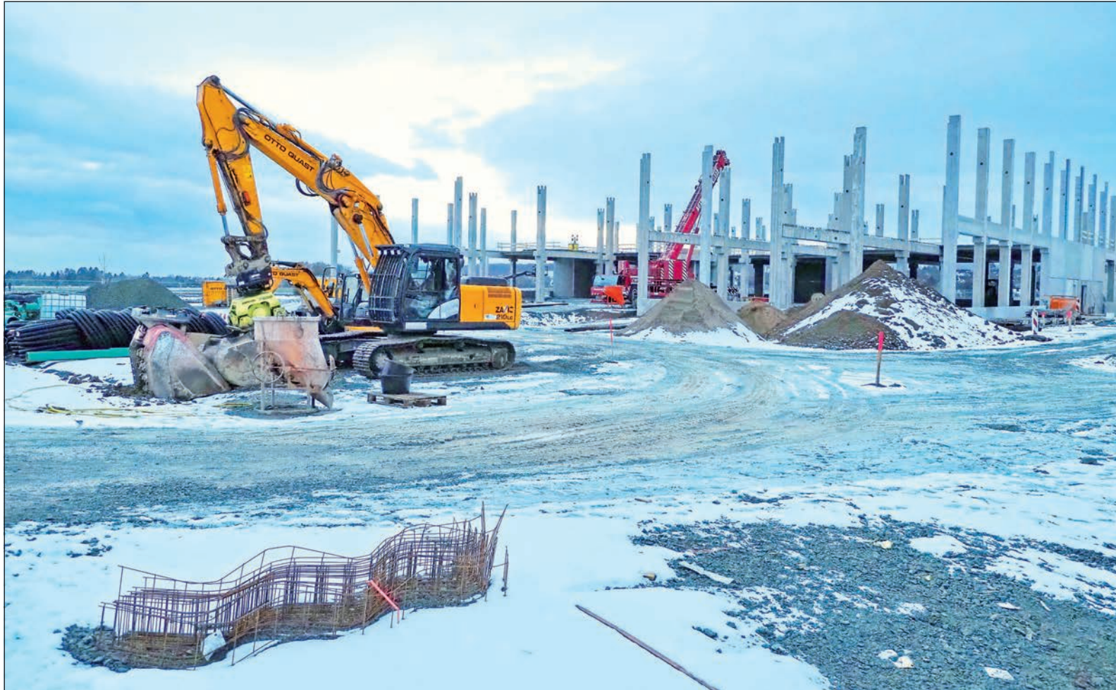
Baukräne, Bagger und eine rege Bautätigkeit zeigen an, dass sich neue Unternehmen im Gewerbepark am Wertstoffhof mit Firmenzentralen und Produktionsstätten ansiedeln. Foto: fch
