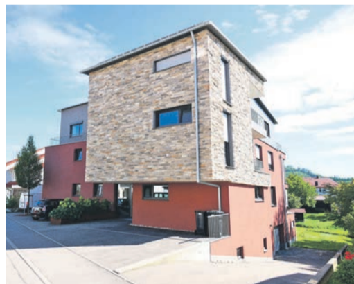
Fassadendämmungen mit WDVS müssen nicht immer verputzt sein. Sie lassen sich auch mit Klinker- oder Natursteinriemchen gestalten. Foto: djaldpuren
