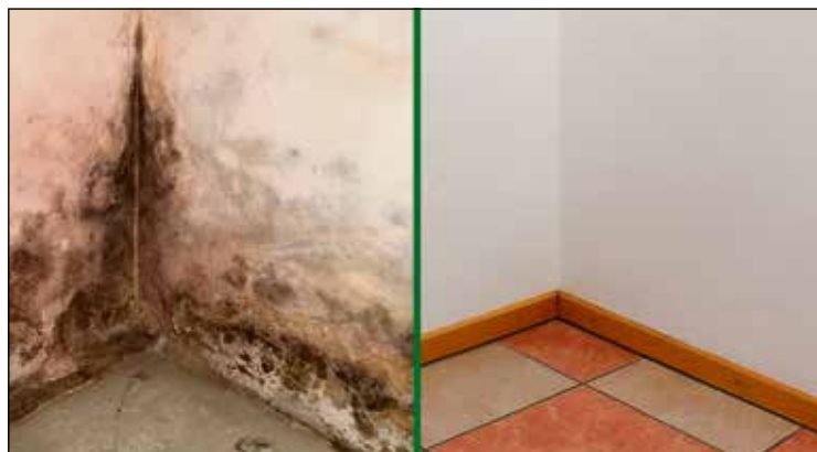
Durch die fachgerechte Sanierung wurden aus dem alten, muffigen Keller wieder attraktive Nutz- und Hobbyräume.
