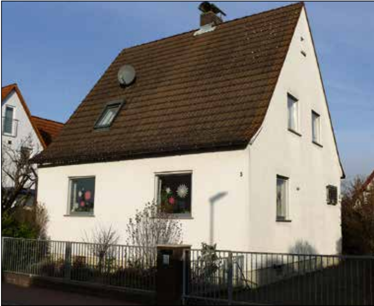
Das Siedlungshaus aus den 50er-Jahren litt an feuchten Kellerwänden. Für ein Haus dieser Bauart und dieses Alters ein typisches Schadensbild. Fotos: Veinal
