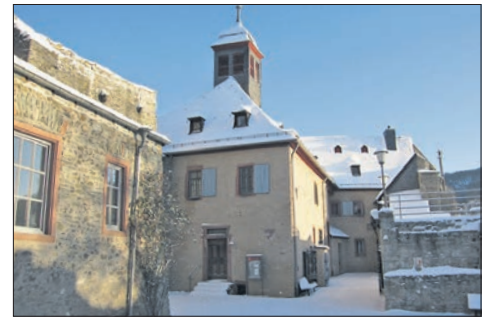
Das Museum auf der Burg hat eine neue Brandmeldeanlage. Foto: Stadt- und Burgmuseum
