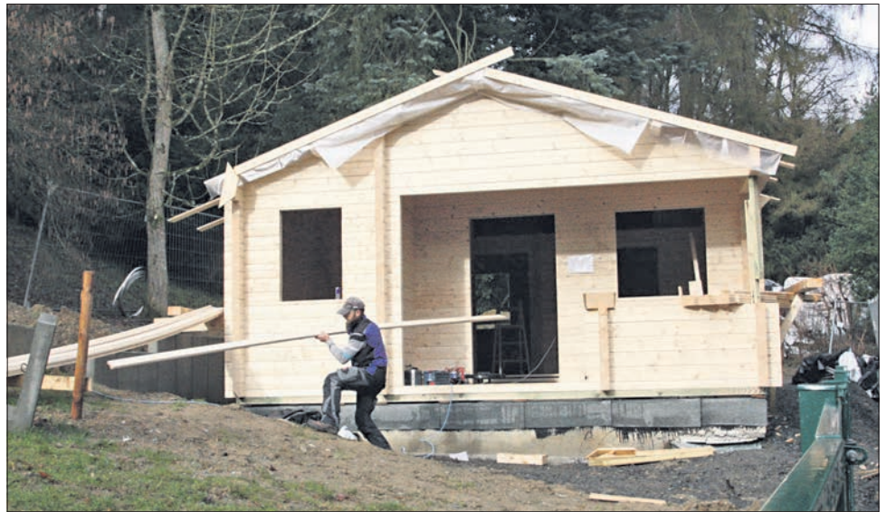
Die Hütte steht, im Laufe der Woche werden Wände gestellt und Leitungen verlegt. Foto: bpa
