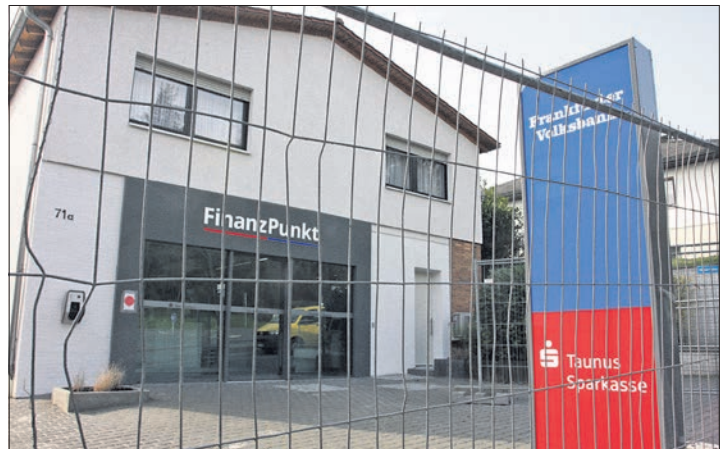
Noch wird am neuen Finanzpunkt in der Wiesbadener Straße gewerkelt.
