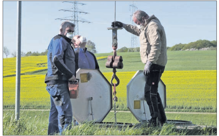
Wassermeister Harald Mager (re.) mit Jörg Wohlfahrt und Johannes Racky beim Austausch einer Pumpe im Trinkwasserbrunnen Bremthal I.
