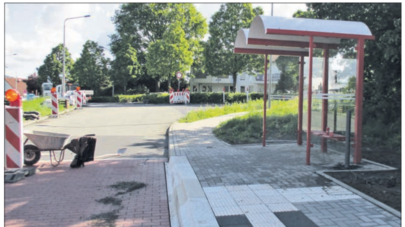
Die umgebaute Bushaltestelle am Hessenring.
