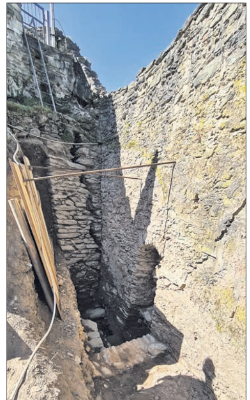
Mit Eisenstäben und Brettern wird das Erdreich vor den schadhaften Mauerteilen abgestützt.
