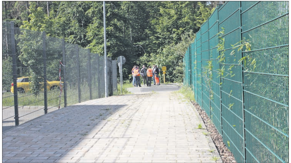
Baustellenbesprechung für den Bau der neuen Bushaltestelle an der B455.
