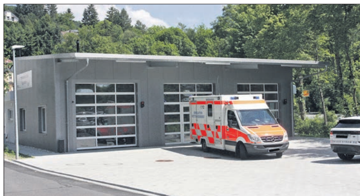
In der vergangenen Woche übergab der MTK die neue Rettungswache an den Malteser Hilfsdienst. Foto: Beate Palmert-Adorff
