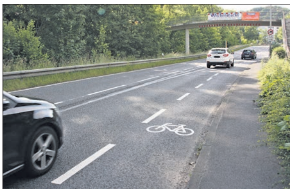
Die Mittelspur wurde versetzt und die Insel neu eingezeichnet, damit mehr Platz für Radfahrer bleibt. Foto: bpa
