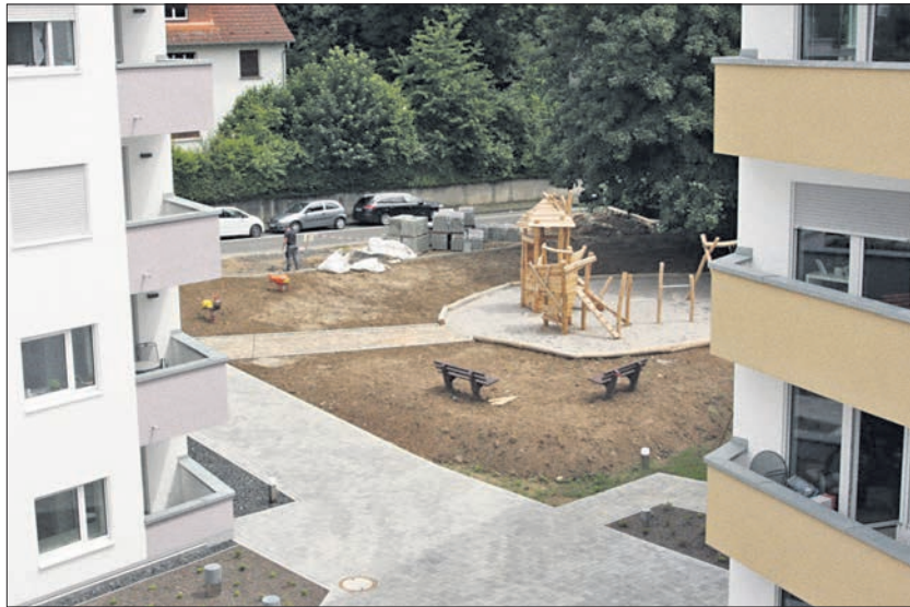
Blick von der Dachterrasse aus auf den Spielplatz und die künftige Rasenfläche. Dahinter liegen Pflastersteine für acht öffentliche Parkplätze. Foto: bpa
