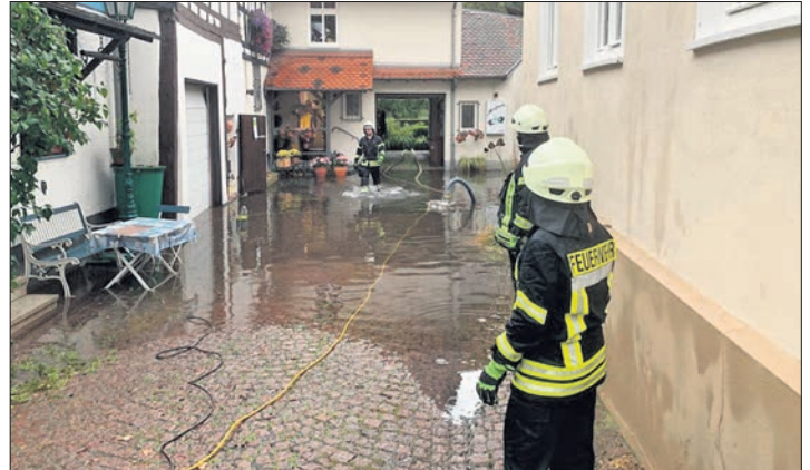
In der Untergasse pumpte die Feuerwehr das aufgestaute Regenwasser mit einer starken Pumpe in den Bach. Fotos: ffw/privat
