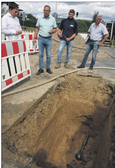
Alexander Simon lässt sich von Uwe Rüger, seinem Mitarbeiter und Matthias Müller (v.li.) die Arbeitsweise des Spülbohrers erklären.
