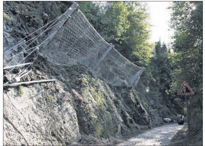
Stahlnetz auf kahlem Felsen. In zwei Jahren schon, so das Bauamt, werde es begrünt sein. Foto: Beate Schuchard-Palmert
