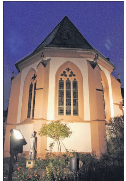
Zwei moderne LED-Strahler beleuchten den Chor des spätgotischen Kirchenschiffs der Talkirche. Ein weiterer Strahler wurde auf die Mauer des Südzwingers der Burg auf dem Felsen hoch über dem Parkplatz hinter der Kirche ausgerichtet. Foto: Julia Palmert
