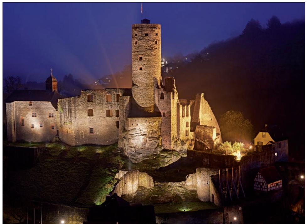
Alte und neue Burgbeleuchtung auf einen Blick – die Nordmauern erstrahlen im weißen Licht der modernen LED-Lampen, die Mauern am Palasgarten auf der Westseite sind noch in das gelblichere Licht der bisherigen Natriumdampfstrahler getaucht. Foto: www.adler-photoart.de
