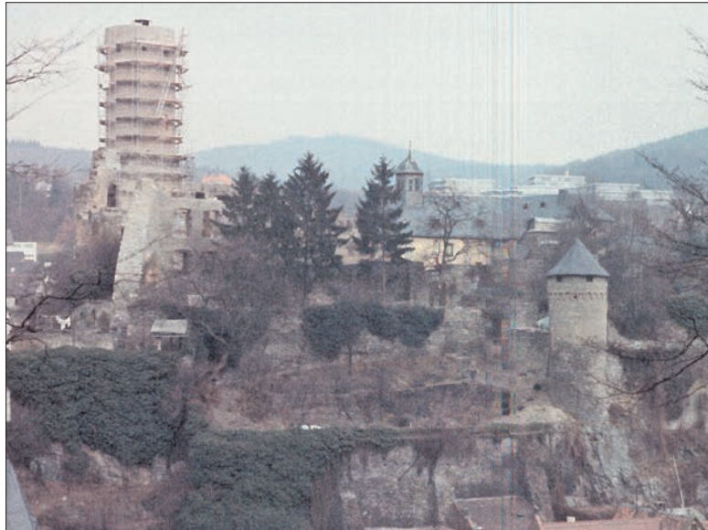
Diesen Anblick wie auf dem Foto von 1971/72 werden die Eppsteiner wohl bald wieder haben – der Bergfried muss eingerüstet werden. Foto: BEBAG mbH
