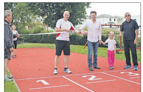
Die TSG Eppstein nutzte die sportliche Zwangspause im Frühjahr und sanierte Laufbahn und Weitsprunganlagen – das Foto zeigt sie bei der Einweihung im Juni. Fotos: EZ-Archiv
