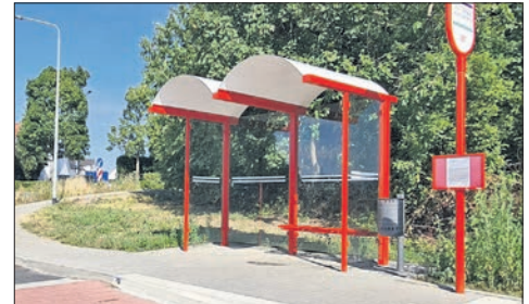
Die bereits 2020 barrierefrei ausgebaute Bushaltestelle im Hessenring. Foto: Stadt Eppstein
