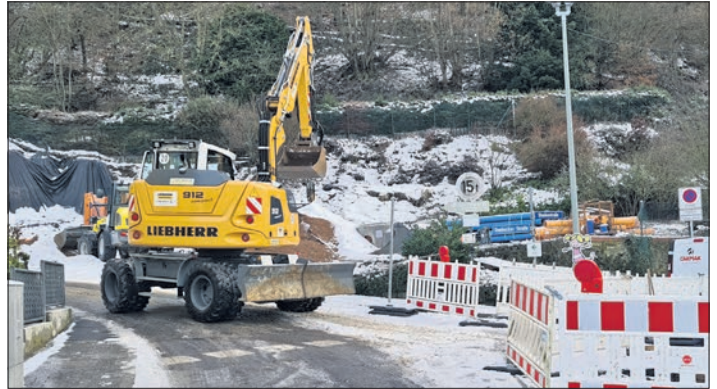
Der heftige Wintereinbruch hat die Bauarbeiten in der Gimbacher Straße verzögert, aber die Bagger rollen weiter. Foto: Stadt Eppstein
