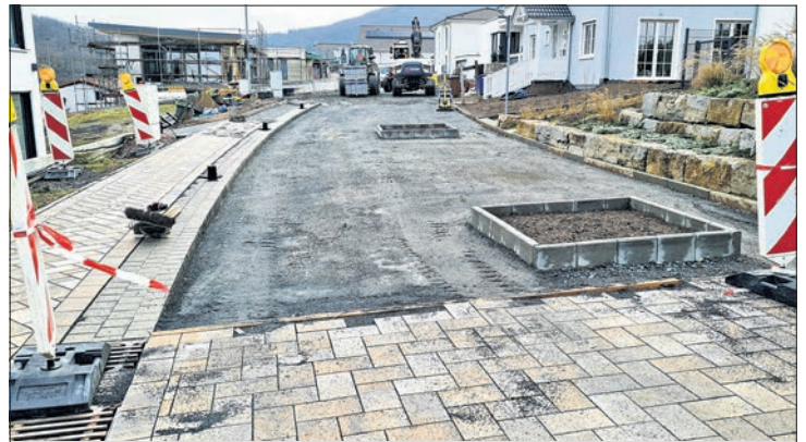
Gehwege und Pflanzfelder für Bäume im Wohngebiet auf dem Bienroth sind angelegt. Foto: Stadt Eppstein
