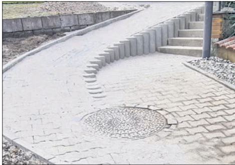
Eine Rampe erleichtert bald den Weg in der Hainbuchenstraße. Foto: Stadt Eppstein
