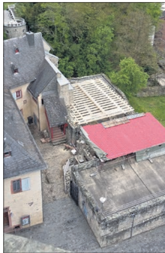
Die Juchhe-Baustelle 2017 vom Bergfried aus gesehen – die Balkenlage für die Überdachung ist frisch eingebaut. Unter der roten Abdeckung zwischen Juchhe und Mainzer Keller finden Ausgrabungen statt. EZ-Archiv
